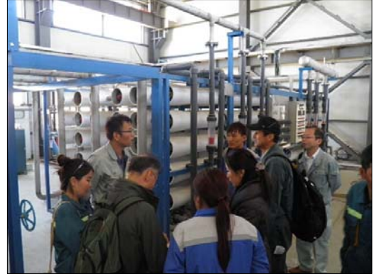
写真-12 現地視察・技術指導（新浄水場）
