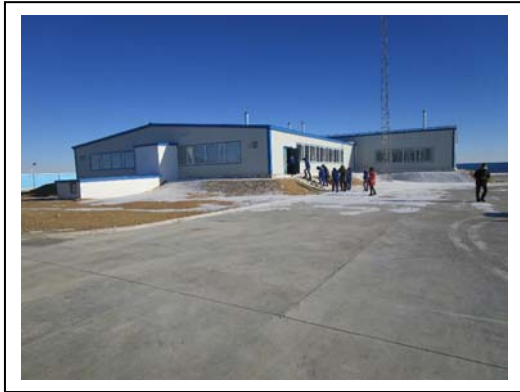
外観（水処理施設棟）
