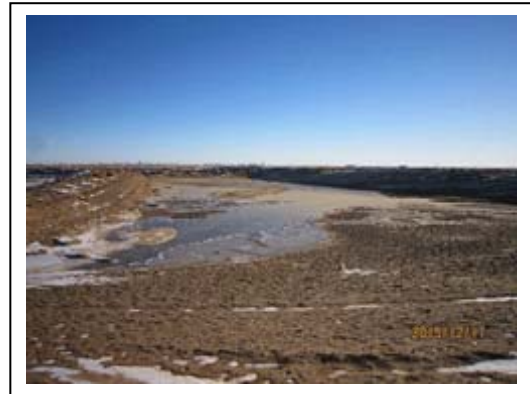
既設下水処理場
