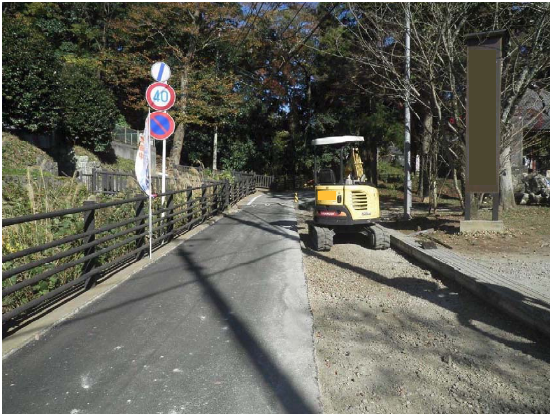
現場の作業状況
