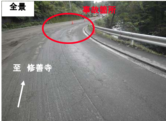
事故発生箇所付近骨材飛散の状態
