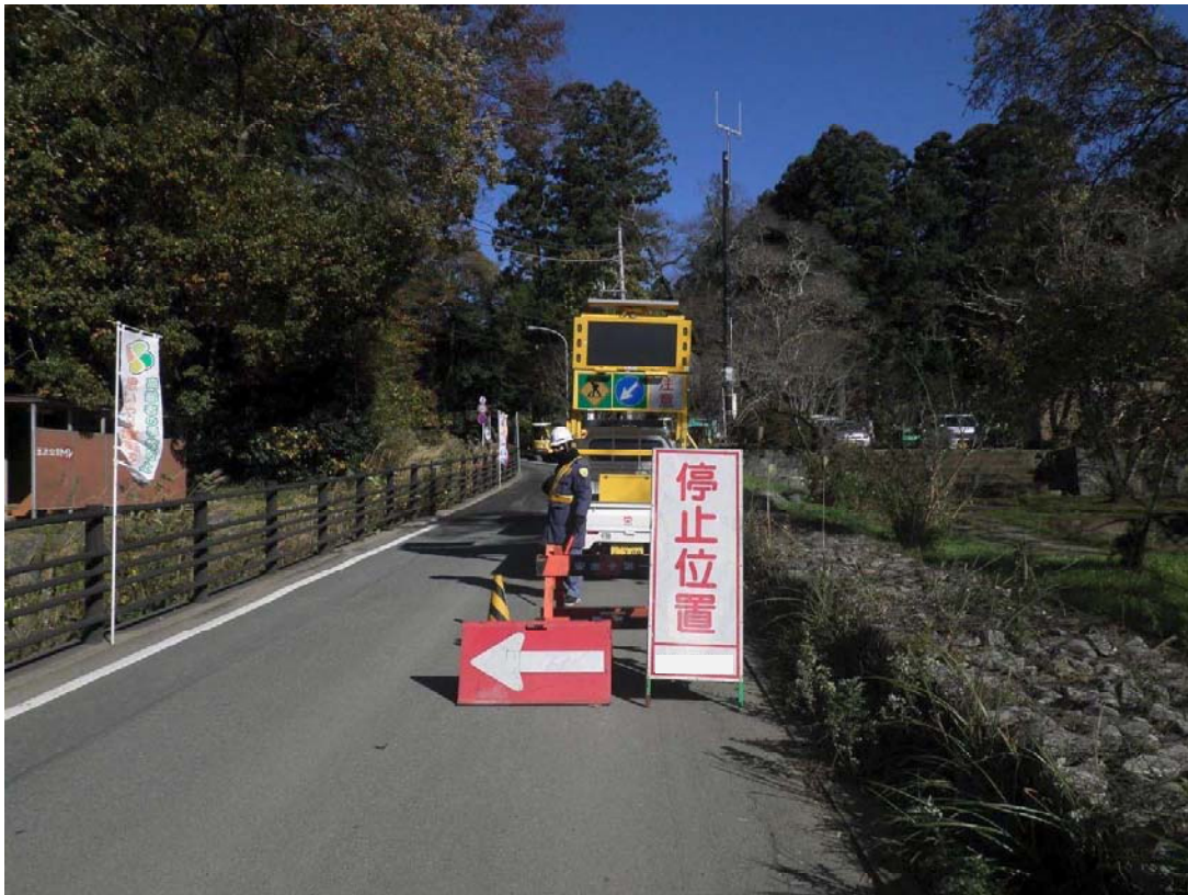
工事区間前後の交通規制の状況
