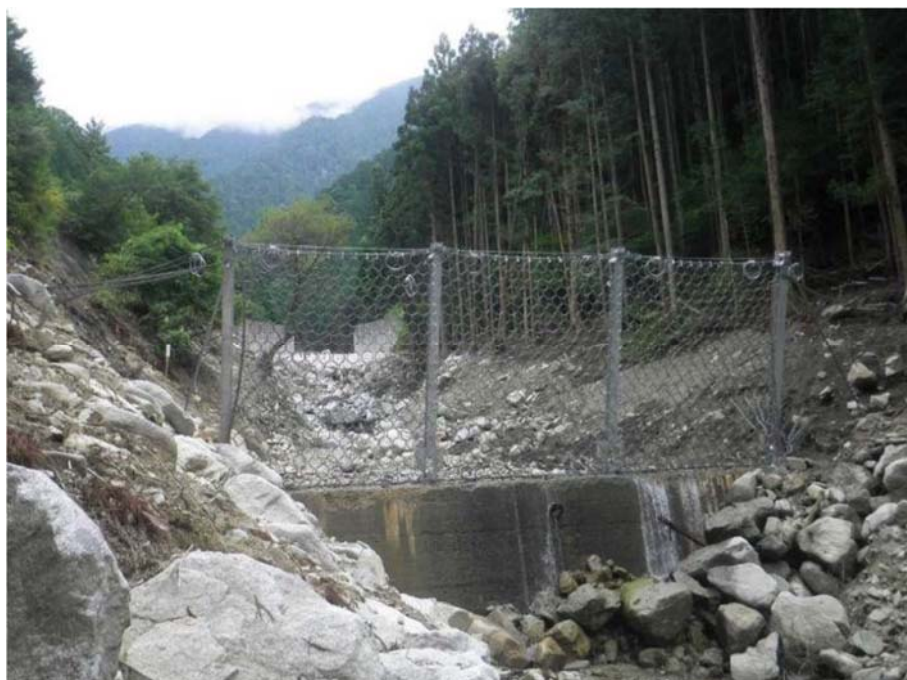
図 5.12.2 強靱ワイヤーネット工法（長野県南木曾町梨子沢）
