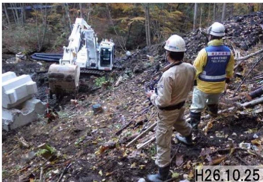
図 5.12.1 遠隔操作無人化施工のバックホウ（平成26年（2014年）噴火時 鹿ノ瀬川）
