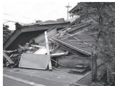
（平成19年 新潟県中越沖地震の被害）
