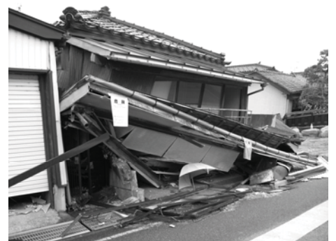
（平成19年 新潟県中越沖地震の被害）
