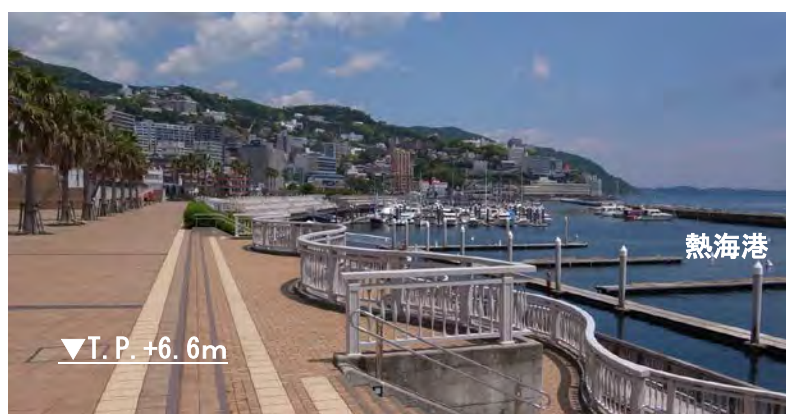
図 1-17 熱海港海岸防潮堤の整備状況
