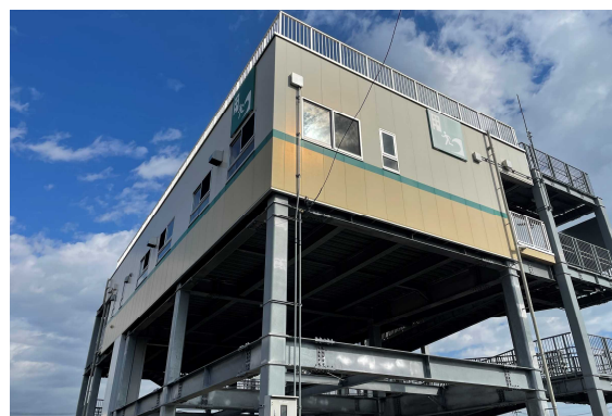
屋根やスロープ、通信設備等の設置事例
