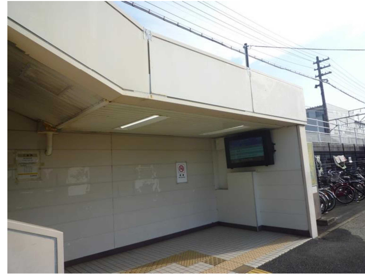
設置状況（遠景）
