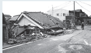
▲平成28年熊本地震で倒壊した木造住宅
