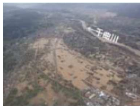
[千曲川における浸水被害(長野県長野市)]
