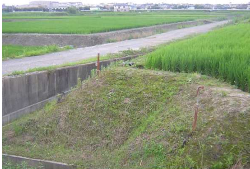
図 2-6 農地の盛土の様子
