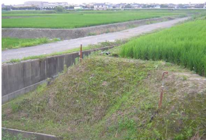
図 2-6 農地の盛土の様子
