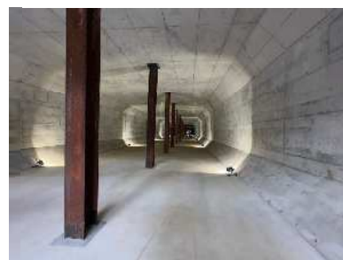
西側函体内 上流を望む
