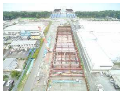
県施工区間 上空から下流を望む
