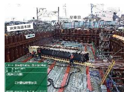
HEP&JES工法 下流西側から望む（発進立坑）
