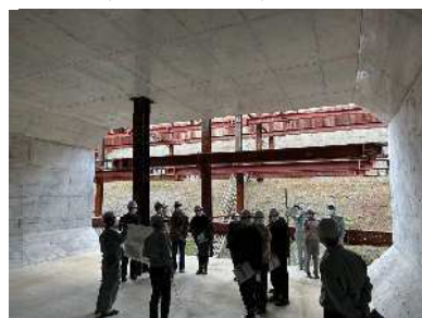
西側側面函体内 下流を望む
