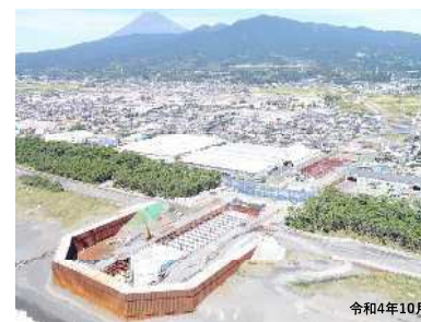
ドローンによる上空写真
