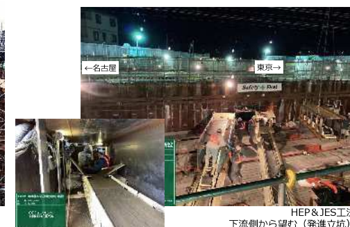
エレメント内掘削状況
