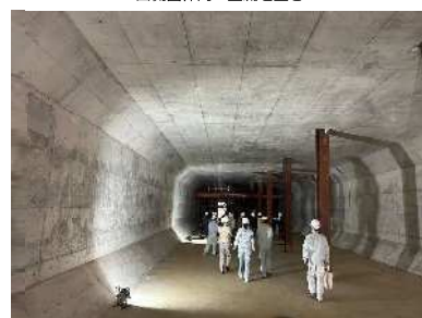
西側函体内 上流を望む
