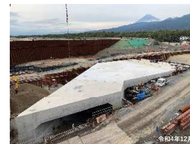
放水路吐口部を望む
