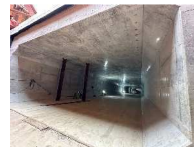
東側函体内 上流から吐口部を望む
