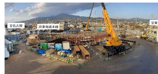
J R 施工区間全景 HEP&JES工法
