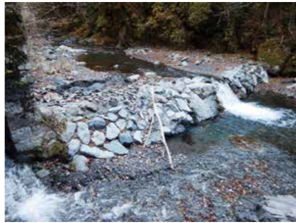
改修して再利用する取水堰堤
