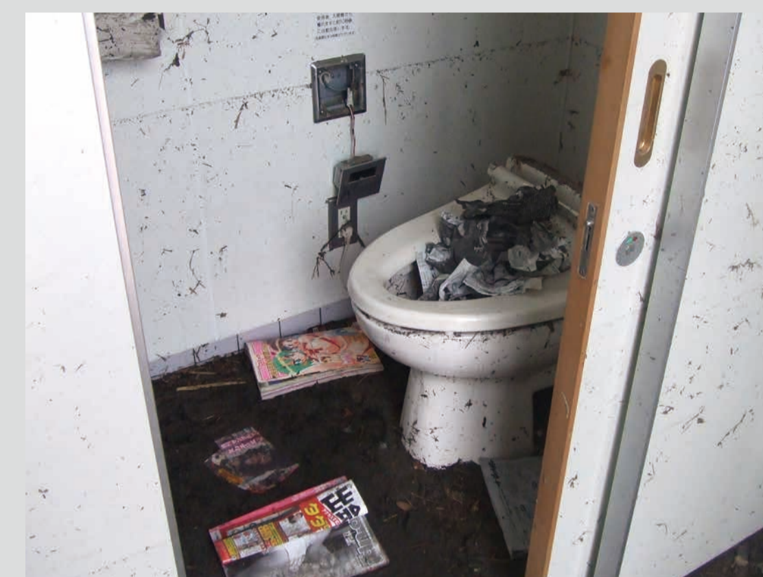
汚物が詰まったトイレ
