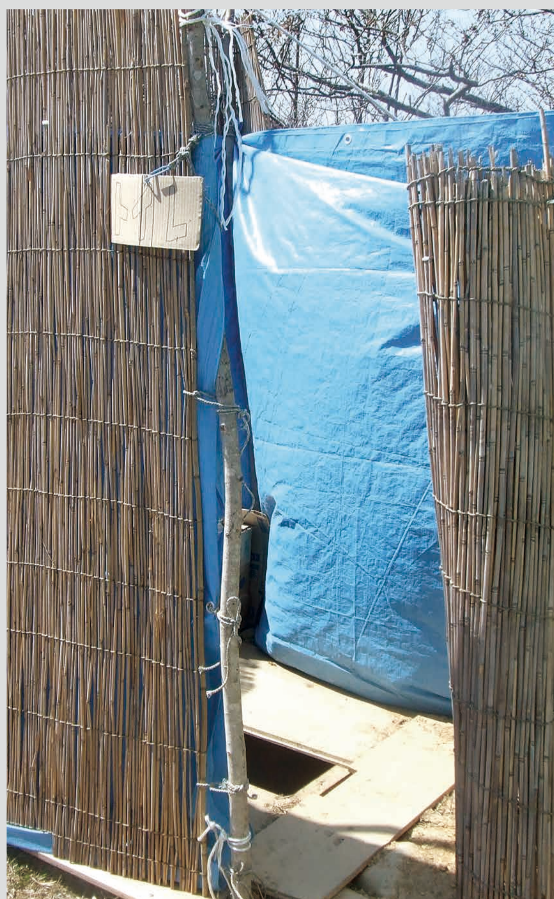
穴を掘ってつくったトイレ
