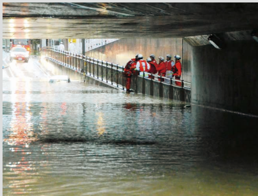
アンダーパスの浸水
