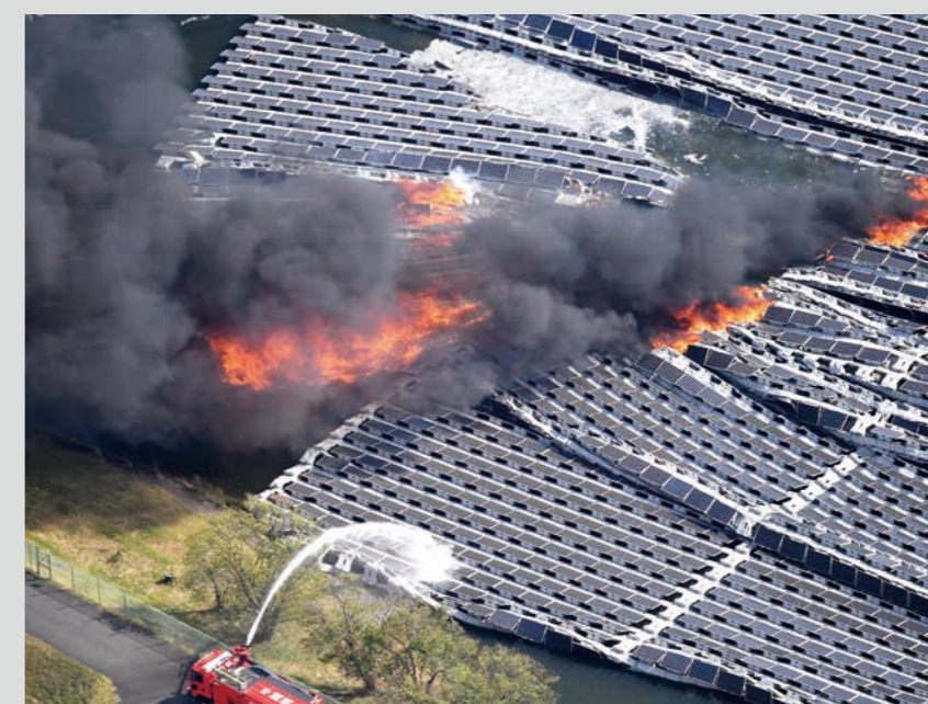
破損した太陽光発電パネルに感電したり、発火する危険
