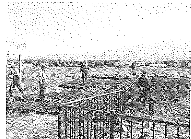
砂を充填しながらパレットを徐々に固定
