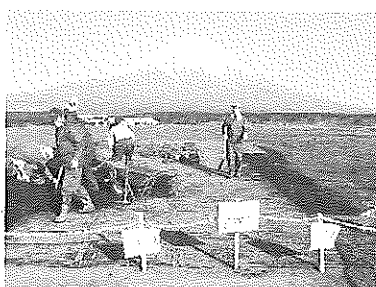
パレット周囲に砂を盛って段差を解消
