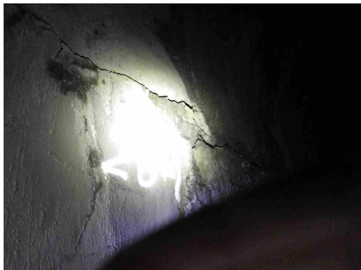
田野口トンネル(覆工の剥離)
