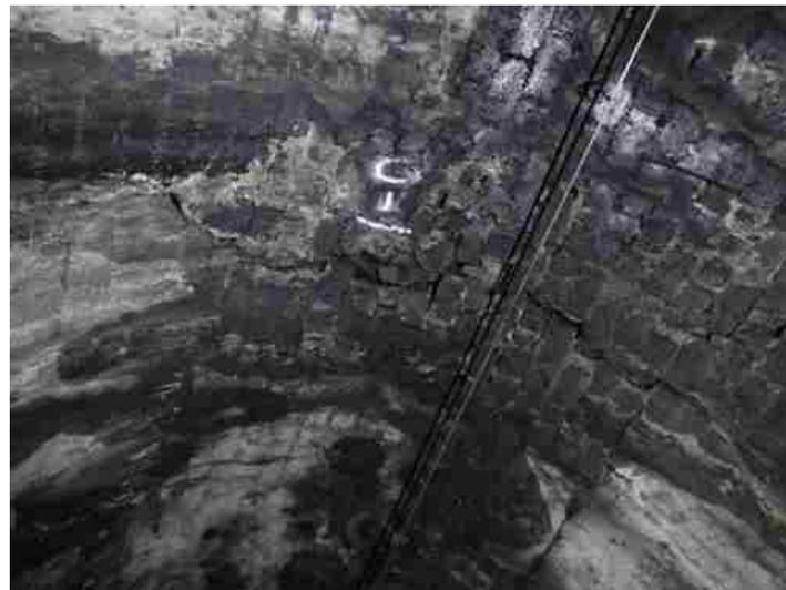
澤間トンネル(覆工のひび割れ)
