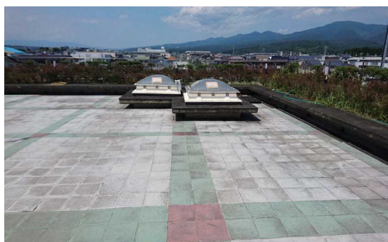
▲試験施工前の裾野市立鈴木図書館屋上
