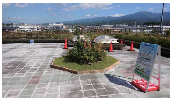
▲試験施工後の裾野市立鈴木図書館屋上
