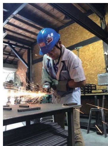
▲鉄を切断し、組み合わせ、溶接する様子。
