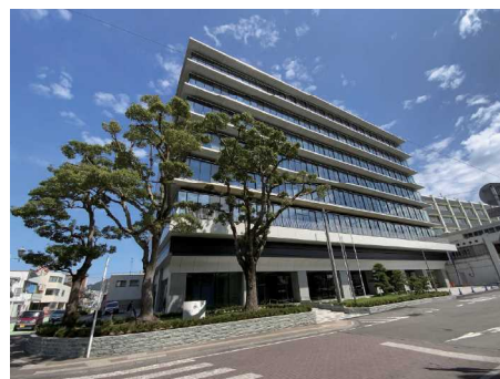
▲焼津市役所新庁舎の電気設備工事施工。
