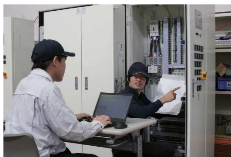
▲制御システムの工場出荷前の試験作業
