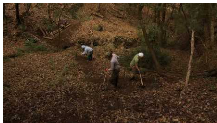
▲整備の様子。1200年前の古道が続く
