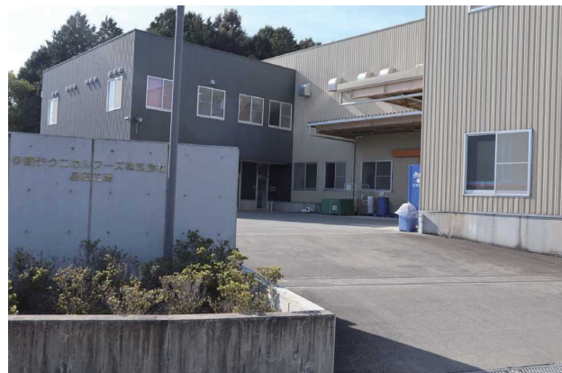
▲2015年に建設した島田工場
