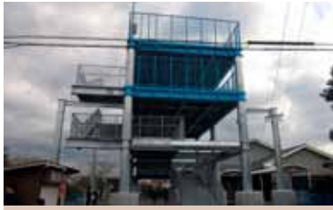
津波避難タワー（焼津市）
