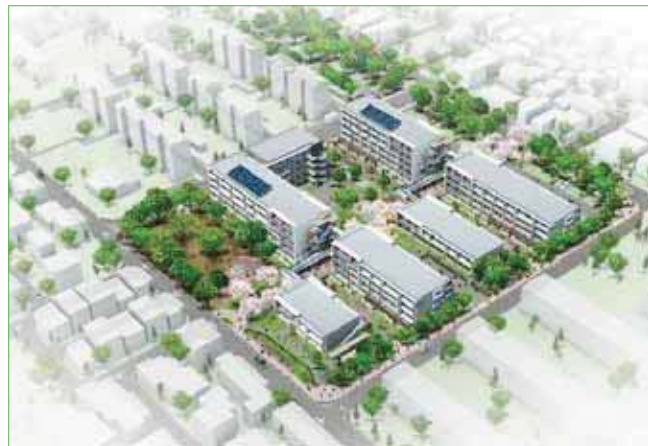
県営東部団地（建設中） 所在地 静岡市葵区
