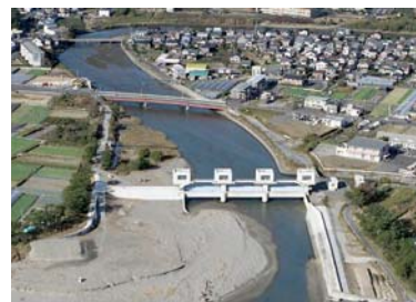
津波対策水門の整備
