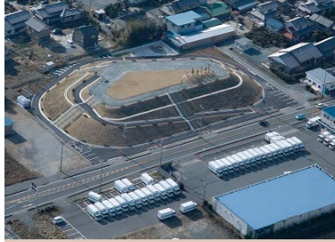
津波避難マウント(命山)の整備
