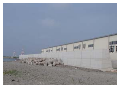
防潮堤の整備
