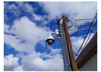
WEBカメラ設置 （富士市浮島排水機場）
