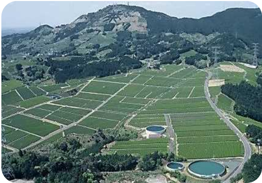
国営掛川調整水槽 (掛川市)
