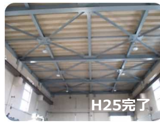
排水機場（建屋）の補強 （伊豆の国市堂川地区）
