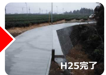
崩落した農道法面の復旧 （牧之原市谷田地区）
