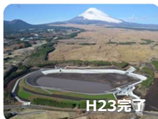
槌の木川調節池（裾野市）
