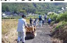
未舗装農道の舗装
