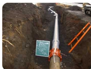
用水管補修（御殿場市）
