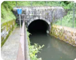
深良用水隧道出口
