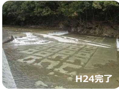
H24完了 魚道の整備 (藤枝市滝沢地区)
