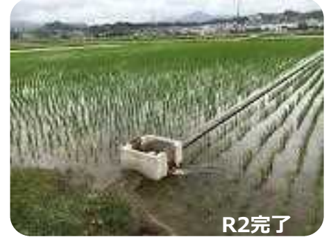
用水のパイプライン化 (浜松市中川地区)
