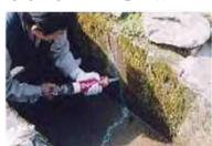
ひび割れの補修
