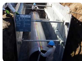
農業用水管改修（裾野市）
