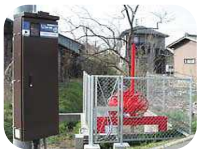
除塵機の設置
