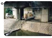
周辺河川より取水
