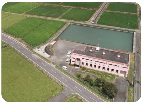
浅羽揚水機場（袋井市）
