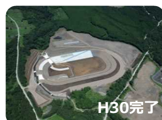
抜川調節池（小山町）
