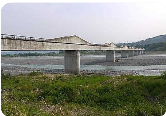
大井川水路橋（島田市）
