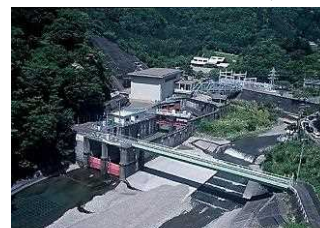
大井川用水 (川口取水工)
