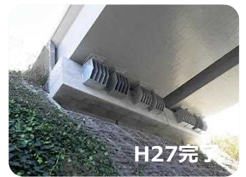
排水路の補強 （浜松市段子川排水路地区）
