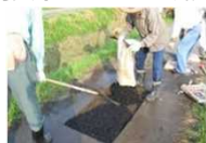
農道の部分補修
