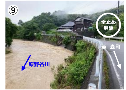
(-)大和田森線 掛川市原里 路肩欠損
