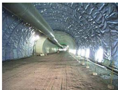
防水シートの施工例
