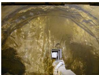
吹付コンクリートの施工例
