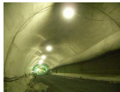
覆工コンクリートの施工例
