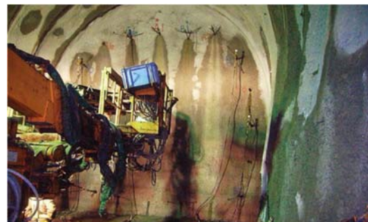
写真 薬液注入工の施工例
