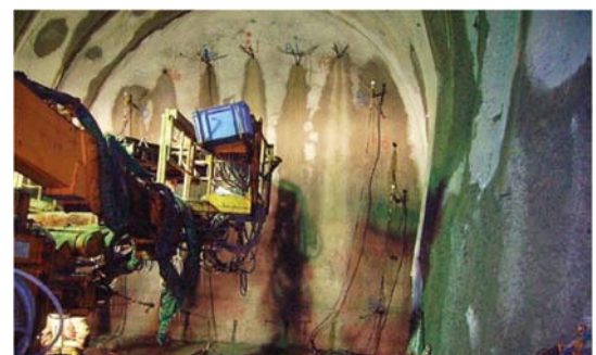
写真 薬液注入工の施工例
