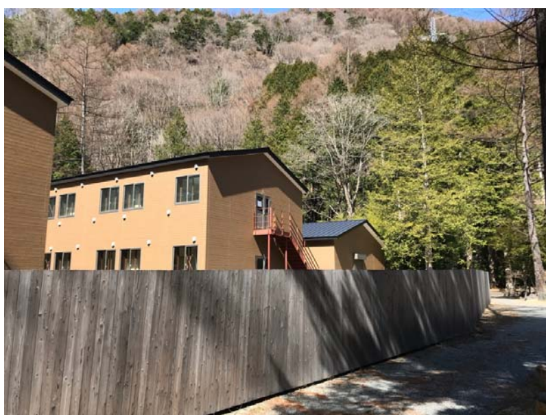
図 1.7 景観に配慮した作業員宿舎と仮設物（仮囲い）の例
