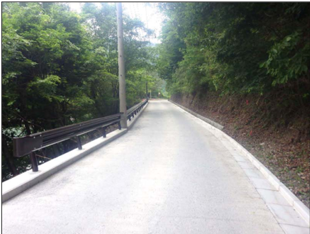
図 1. 15 林道東俣線の改良（舗装）
