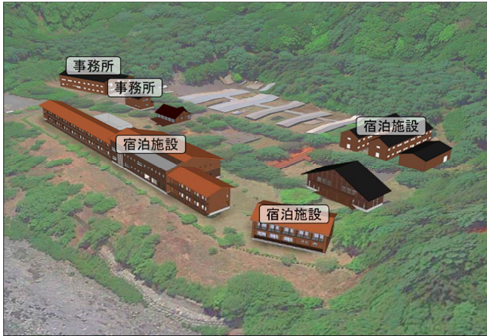
図 1. 16 榎島における工事用宿泊施設の建設
