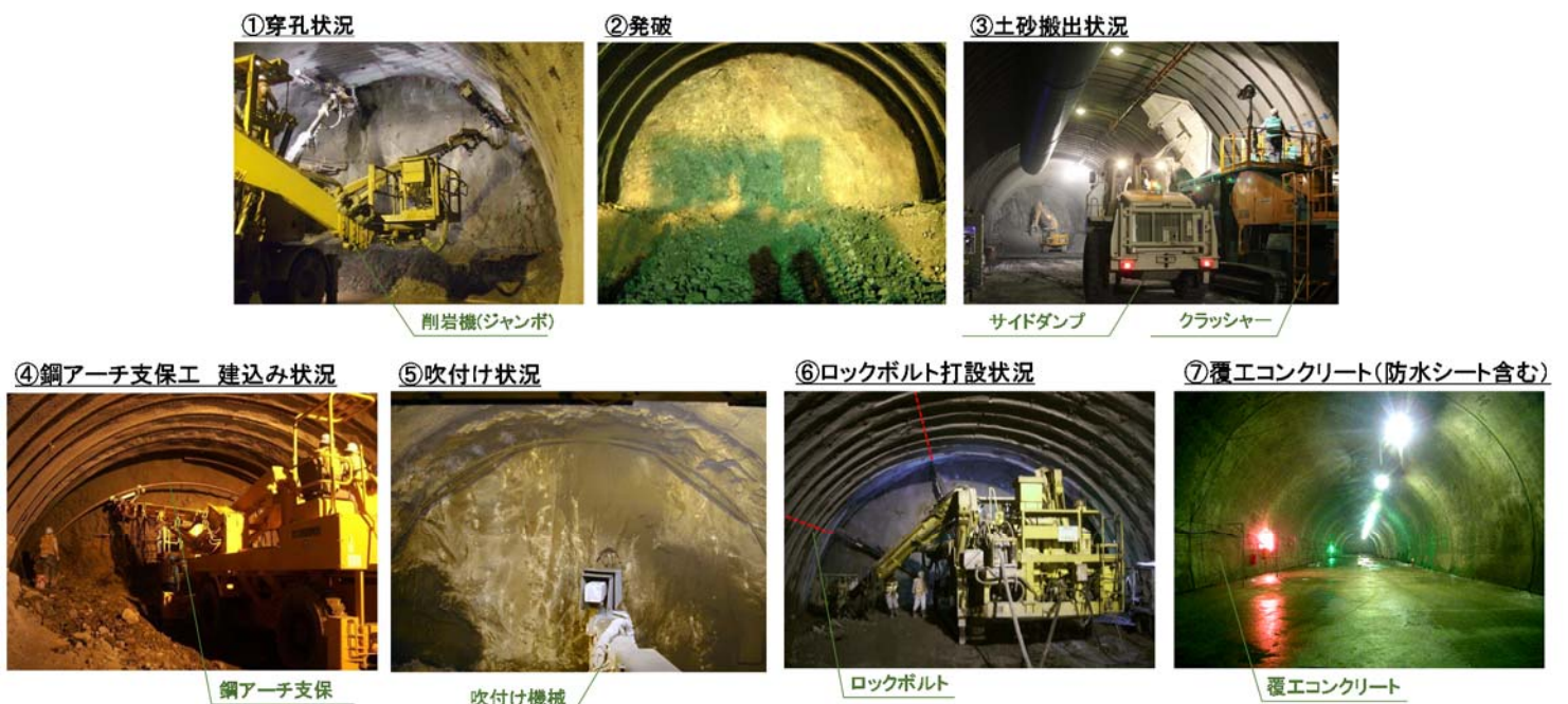
図 2.7 NATMの標準的な施工手順
