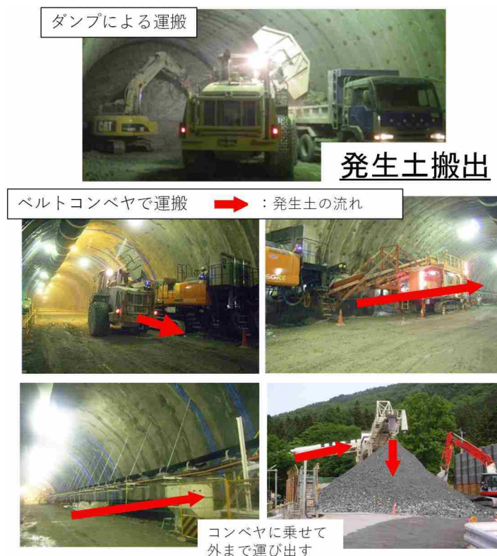
写真 2 発生土の搬出状況
