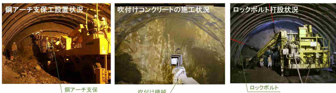
写真 3 支保工の施工状況
