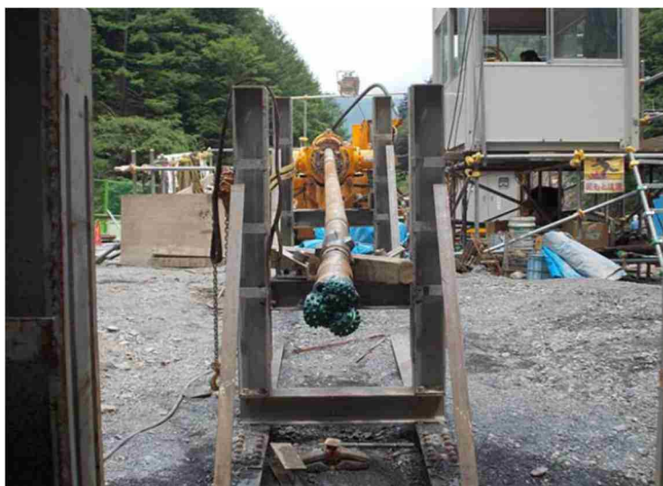
写真 4 高速長尺先進ボーリング（山梨工区）
