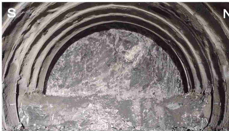
写真 7 先進坑 2 k 7 7 2 mにおける切羽状況
