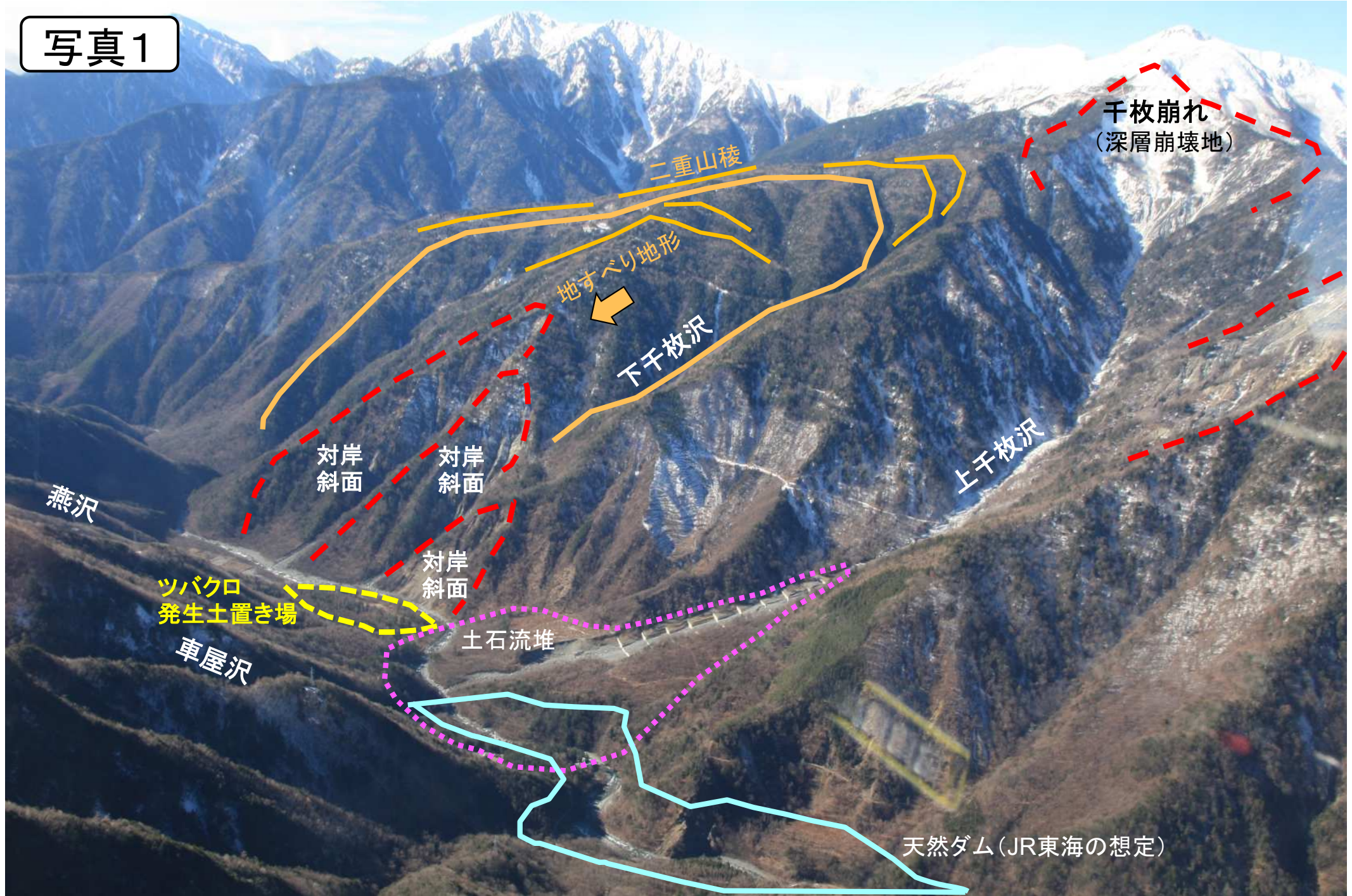
ツバクロ発生土置き場の北側から南西を撮影__千枚崩れ、上千枚沢の土石流堆、対岸斜面 (写真提供__静岡大学名誉教授 狩野謙一氏)
