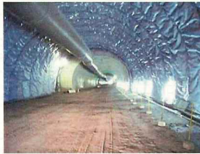
防水シートの施工例
