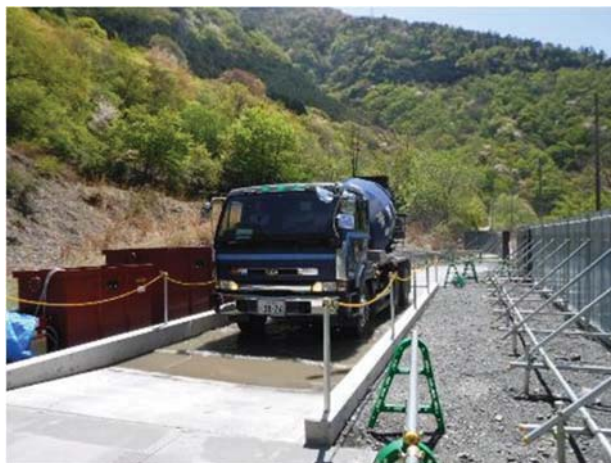
写真 林道入口付近のタイヤ洗浄状況
