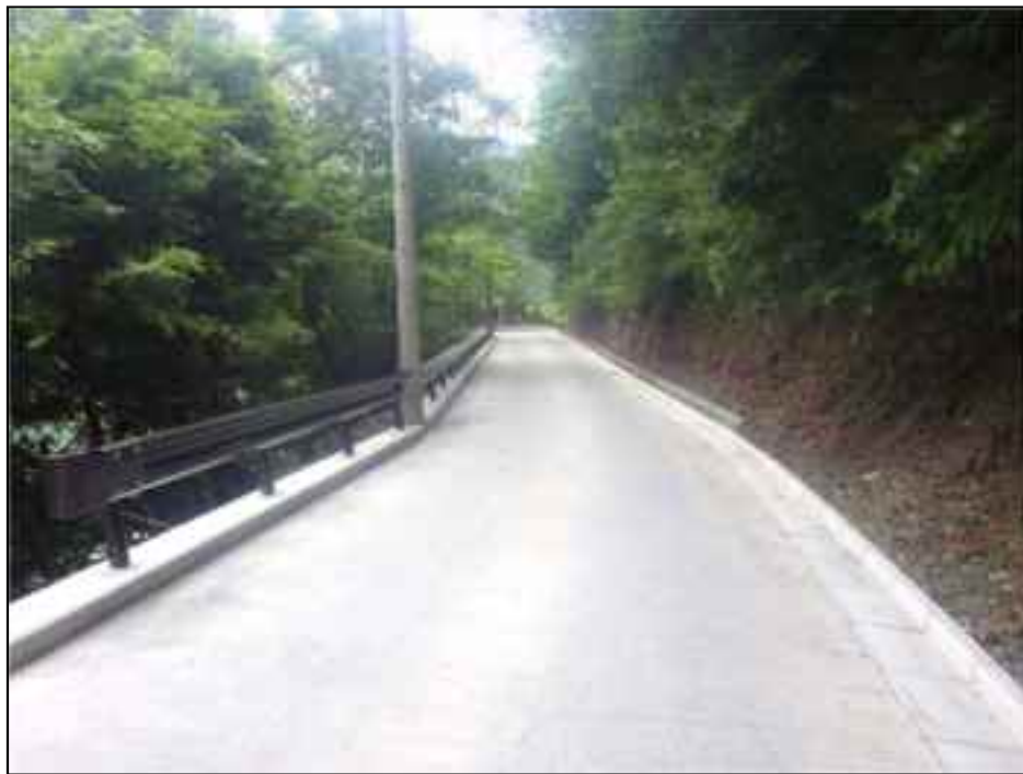
図 9.7 林道東俣線の改良（舗装）
