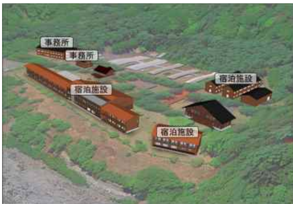
図 9.8 榎島における工事用宿泊施設の建設
