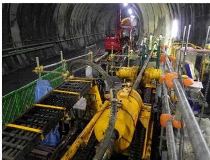
施工写真（山梨工区）
