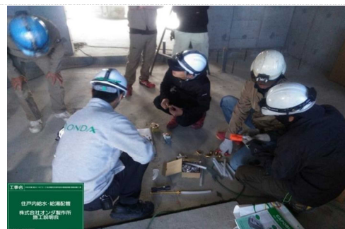
さや管ヘッダー工法メーカー講習会
