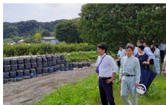
る橋に流木が堆積し、川の流れが阻害され水位が上昇したことにより水があふれ、堤防の裏面が削り取られ決壊した。このため応急復旧工事として堤防の高さ、厚さを確保するため大型土のうを755袋設置した。
