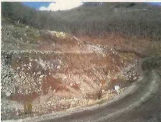
③ 掘削法面の状況
