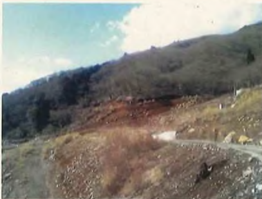
② 盛土法面の状況
