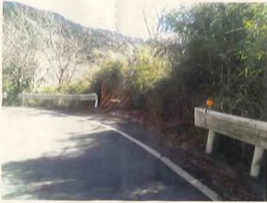
① 市道からの状況(右側が事業地)
