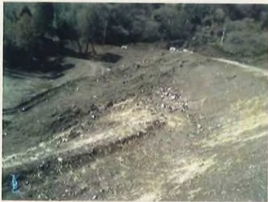
② 崩壊している法面の状況
