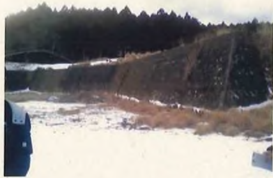
④ 造成地内の擁壁
