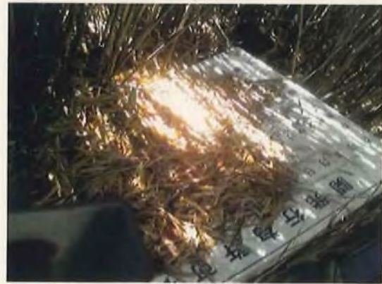
⑥ 倒壊した看板(都計法のもの)
