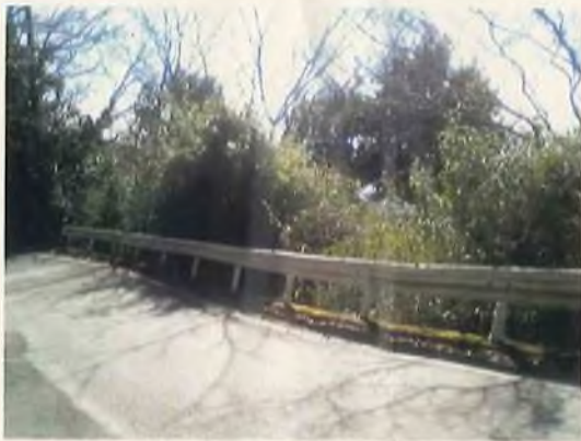
③ 市道からの状況(右側が事業地)
