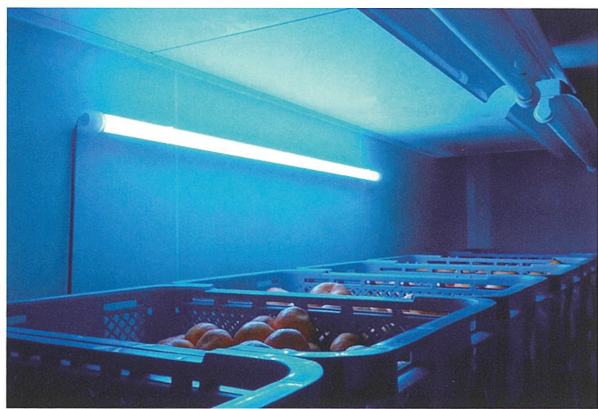
写真3 貯蔵庫壁面に青色LEDを設置
