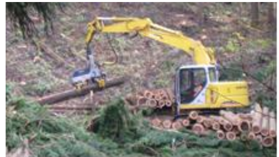
高性能林業機械を使用した作業
