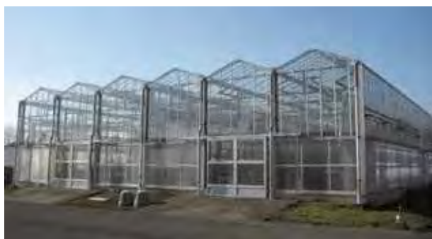
写真4-1 試験に用いたフェンロー型温室
