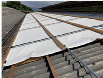
屋根に設置した放射冷却シート
