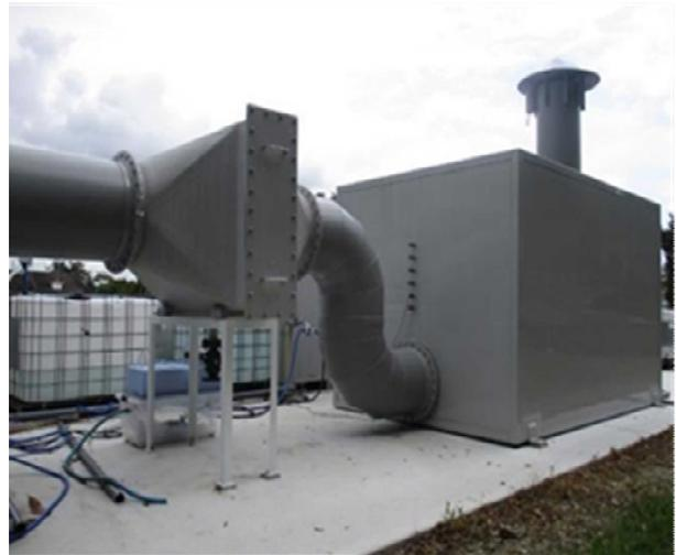
図2 脱臭資材を利用した吸着脱臭装置
