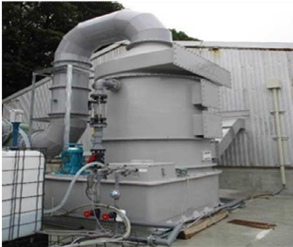
図1 次亜塩素酸水を利用した洗浄脱臭装置
