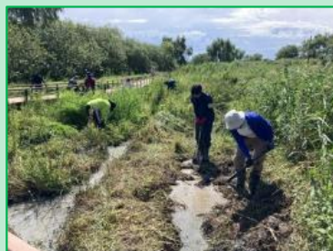
湿地のかく乱作業 ＜麻機遊水地〔静岡市葵区〕＞
