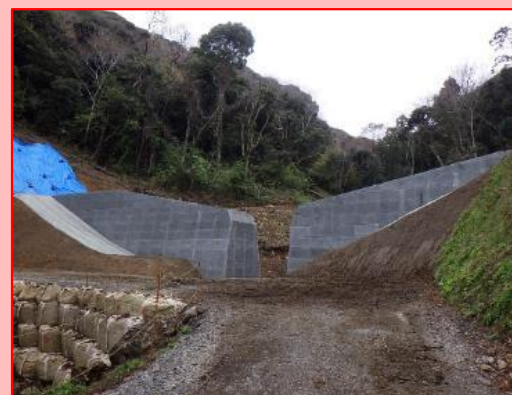
砂防堰堤の整備
