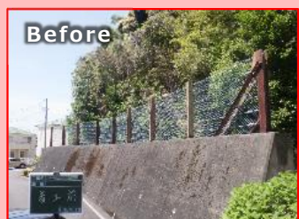
落石防護柵の長寿命化対策 ＜東伊場西急傾斜〔浜松市〕＞
