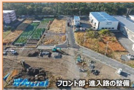
<新貨物ターミナル整備〔沼津市〕>
