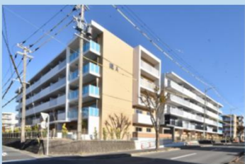
佐鳴湖団地第1工区(145戸)完成 (R5.12月完成)
