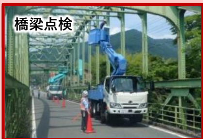
県道富士川身延線（釜口橋）
