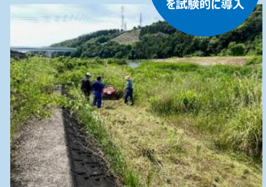
リモコン式草刈機による除草
