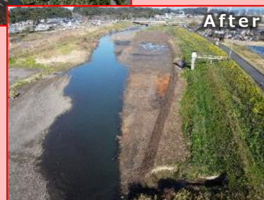
堆積土砂の掘削
