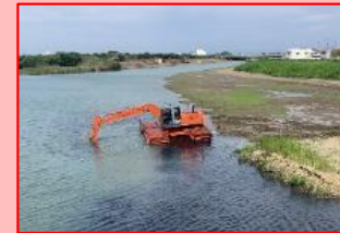
河川改修の実施
