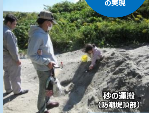
堆砂垣の設置 (防潮堤法面)
