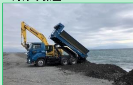
安倍川の掘削土砂を活用した養浜工事
