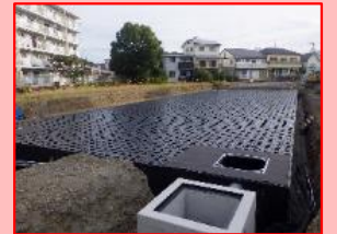
雨水貯留施設の整備
