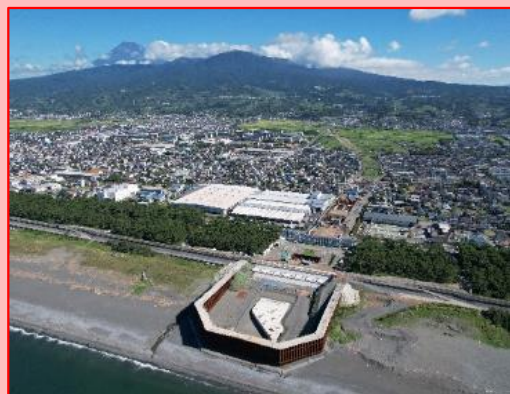
放水路の整備
