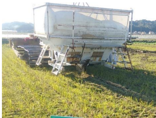
暗渠排水の施工・排水改善
