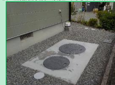
合併浄化槽の設置
