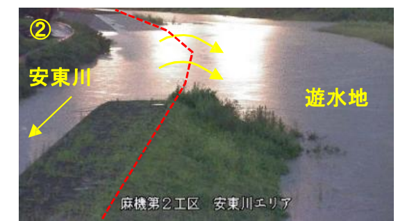
洪水を遊水地に貯留している状況
