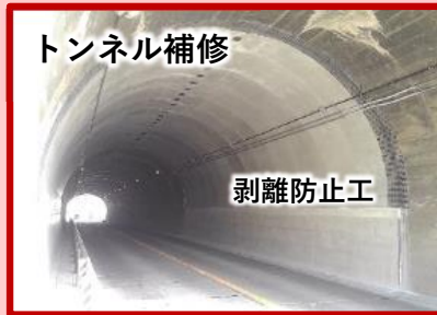
国道414号（多比第1トンネル）
