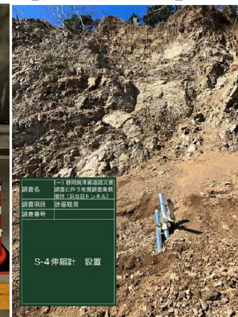
【S-4設置状況】
