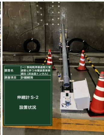
【S-2,3設置状況】
