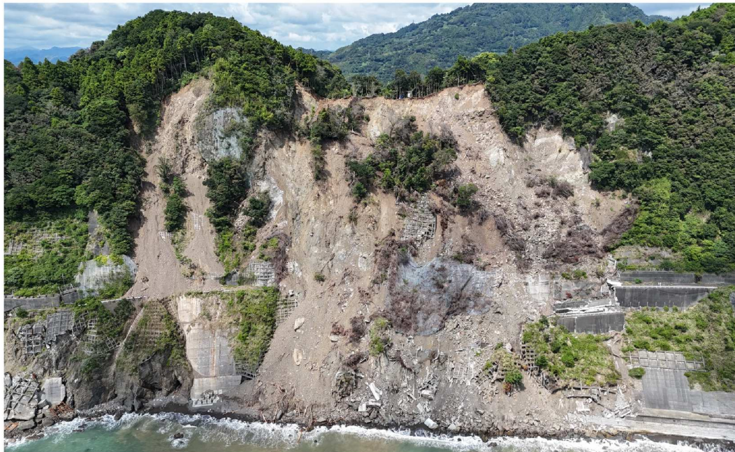
斜面崩壊全景（R6.9.4撮影）
