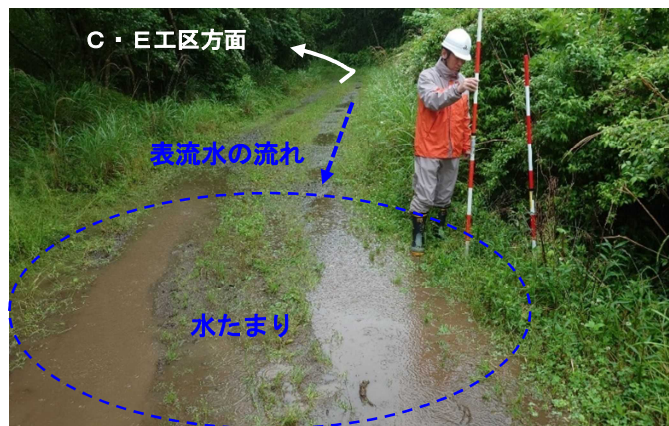
道路がE工区からD工区に向かって下り勾配になっており、D工区内に水たまりができています
