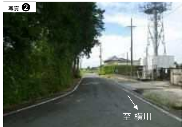
幅員が狭小な区間
