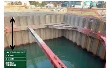
現地盤より約2mの位置から砂礫層となる。透水係数が高く地下水位の高さまで掘削後すぐに冠水する。(橋梁下部工の施工状況)
