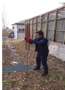
②直管パイプを打ち込む
