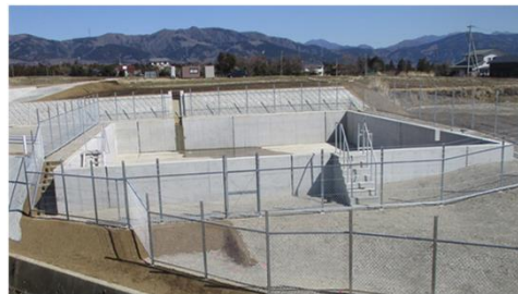
立沢川調整池
