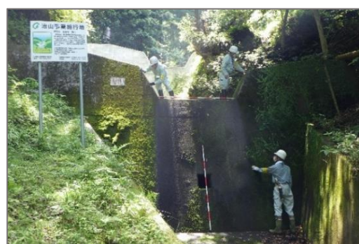
治山パトロールの様子(伊豆市)
