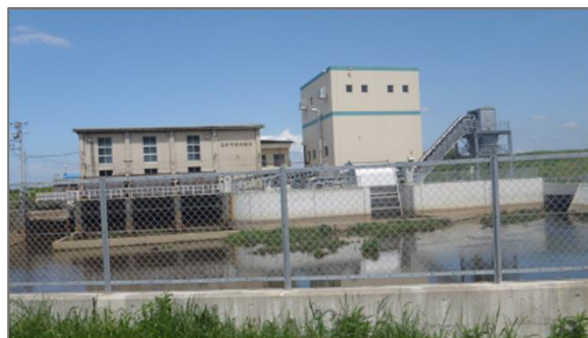
毘沙門排水機場(伊豆の国市)
