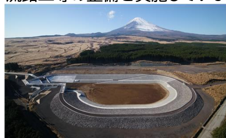
境沢川調節池
