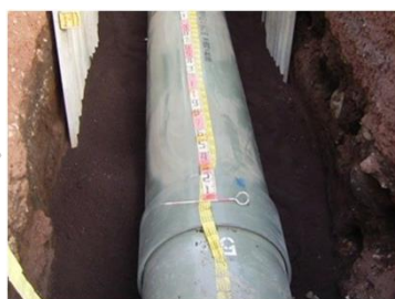
改修工事完了
