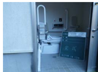
多目的スペース内部
